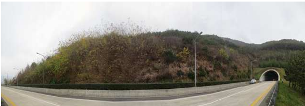
(시점부 절토사면 전경)
